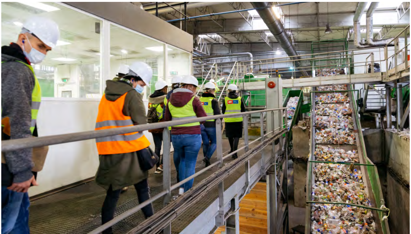
Zakład Utylizacyjny w Gdańsku – sortownia odpadów komunalnych (fot. ZU)
