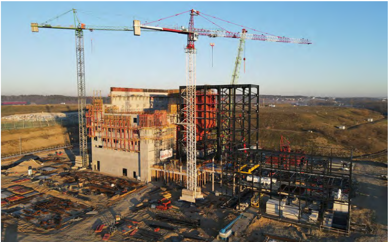
Port Czystej Energii - budowa zakładu odzysku energii z odpadów (fot. PCE)
